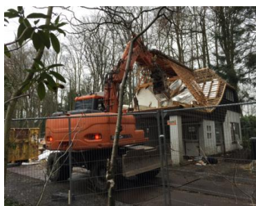
De sloop van de oude villa.
